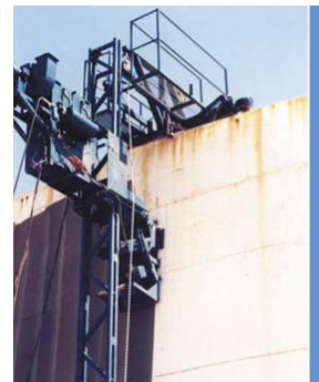
Dispositivo para el granallado externo de tanques
