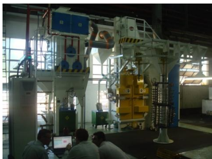
Engenheiros da Cym e Fiat dando partida no equipamento
